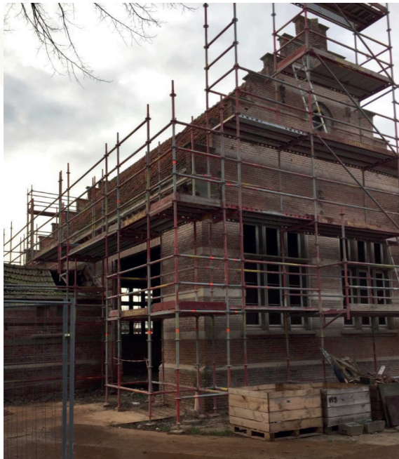
Eén van de klaslokalen in volle restauratie.
